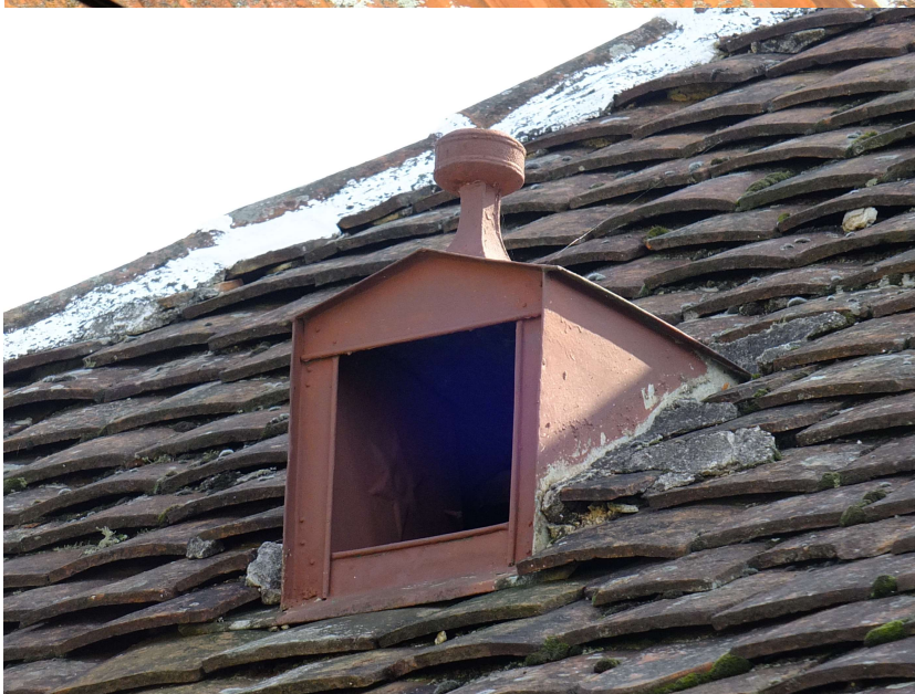
Példák tetőszellőző ablakok bádogos kialakítására
